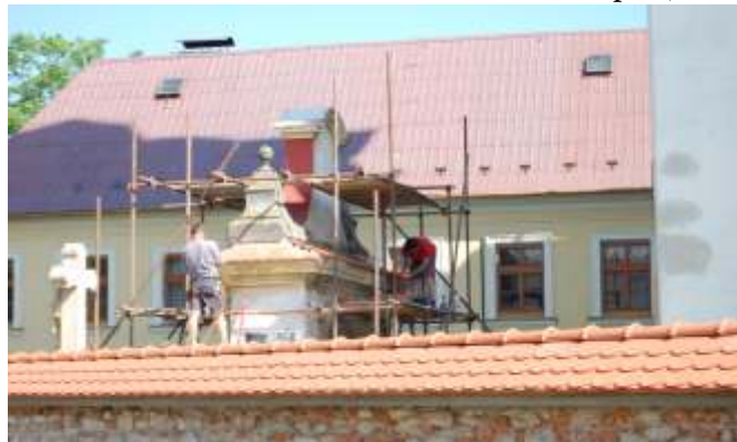
V současné době probíhají práce na opravě zdi a bran kostela.
