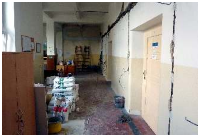
Hlavní pozornost se soustředila na opravu interiéru budovy základní školy. Nasazením pracovníků obecního úřadu došlo nejen k úspoře statisíců korun, ale především tím bylo zabezpečeno dokončení prací ještě před zahájením školního roku.
