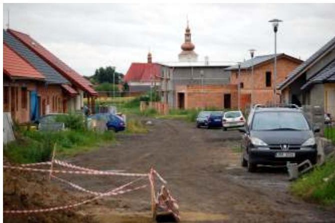
Dotaci ve výši 300 000 Kč se podařilo získat od Ministerstva pro místní rozvoj na akci „Komunikace pro 72 RD Hněvotín, Za Hřištěm – dokončení“, z vlastních zdrojů obec zaplatí rozdíl do výše skutečných nákladů.
