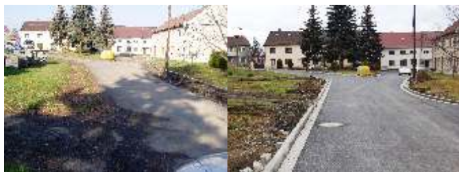
Práce v Kout intenzivn pokračují. Na snímcích je vid t ást komunikace v p vodním stavu a po oprav .
