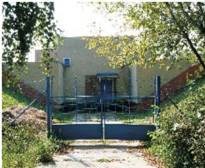
Vodárna ve Skalách je důležitým obecním zdrojem pitné vody
