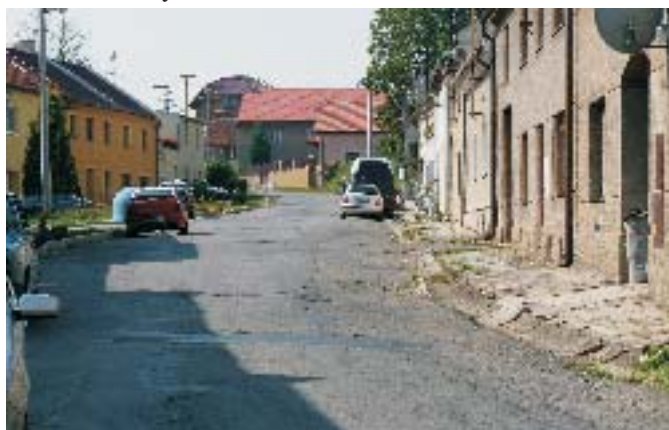
V souvislosti s nadcházející opravou napojení vodovodních přípojek a rekonstrukcí komunikací v části obce Velký Klupoř probíhají přípravné práce.
