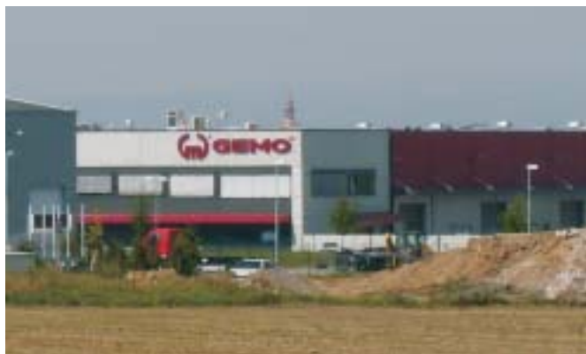
K otázce plánování další výstavby se musí přistupovat s maximální zodpovědností. Nelze bezmyšlenkovitě zastavět každou volnou plochu v obci a jejím nejbližším okolí. To by z Hněvotína byla za chvíli vidět opravdu už jenom věž kostela.
