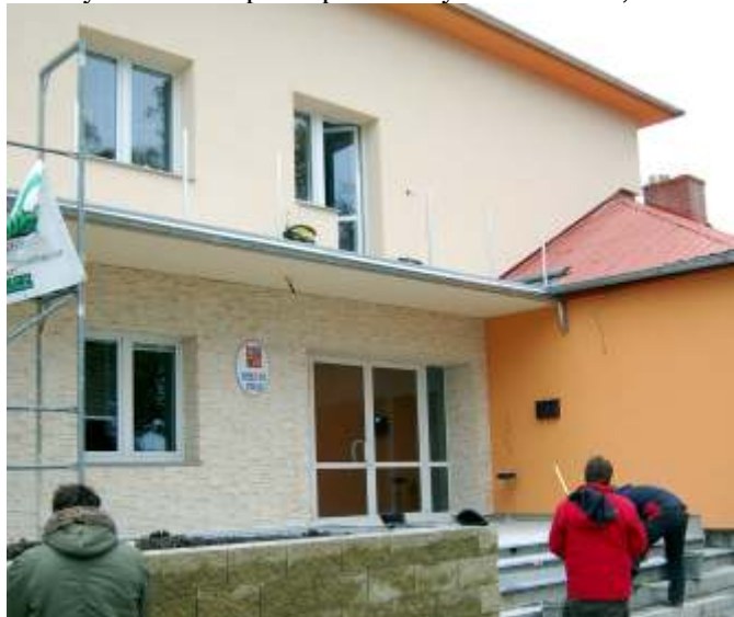
Provedena byla úprava vzhledu a zateplení přední části Kulturního domu s úpravou balkonu a schodiště, včetně klempířských prací a přeložení vedení nízkého napětí a veřejného osvětlení.
