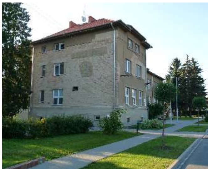
O prázdninách čeká budovu základní školy převlékání do nových šatů, po letech zmizí oprýskaná fasáda. Tu nahradí nový zateplený povrch školní budovy. Pak teprve bude možné provést i úpravy okolí školy.
