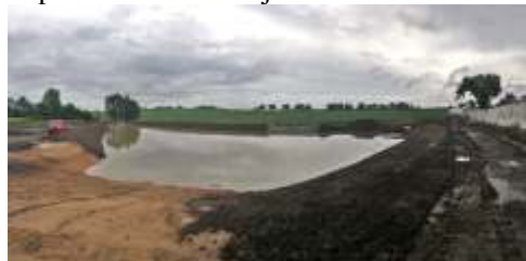
Naplněná retenční nádrž po vydatných deštích.
