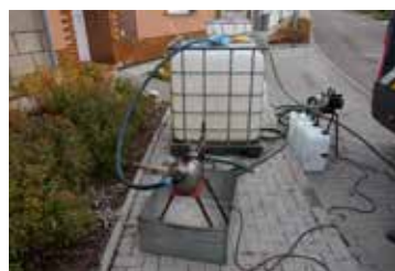
Na Malém Klupoři se čistí vodovod a domovní přípojky strana 3
