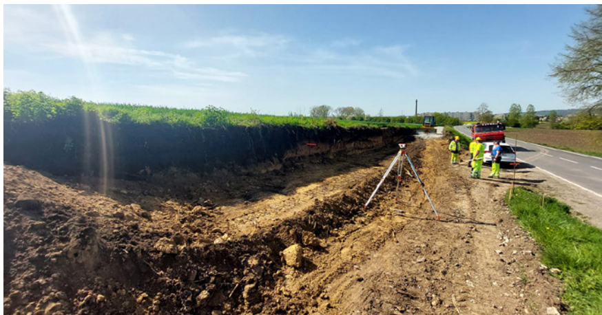
V některých místech nové cyklostezky do Lutína bylo nutné upravit až dvoumetrové výškové nerovnosti v terénu.
